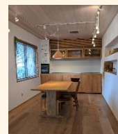
設置工事中のショールーム
